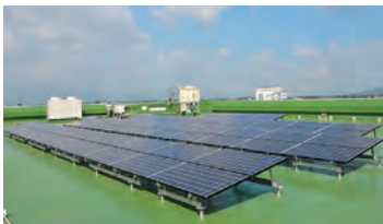
太陽光発電装置(15.0kW)
