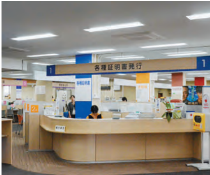
老朽化した照明をLED化し、ロビー、カウンター周辺が明るくなりました。消費電力の減少にもなります。
