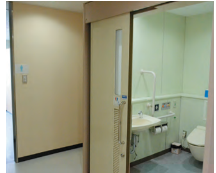
1階から3階のトイレをすべて洋式便座に取替。2階や3階にも1階と同じく身体が不自由な方にも利用できる多目的トイレを新設しました。
