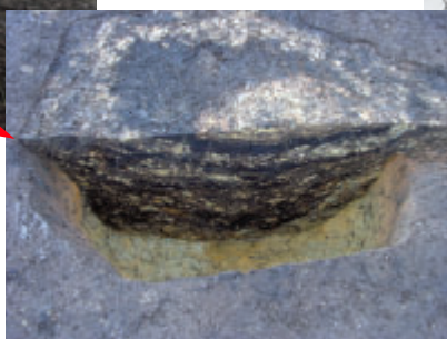
礎石建物の礎石の下部構造 柱が沈まないよう土を締めている
