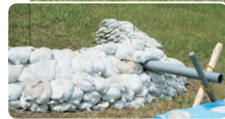
亀裂拡大を防ぐ五徳縫い工法
