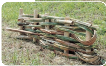
堤防などの崩壊を防ぐ竹柵工法
