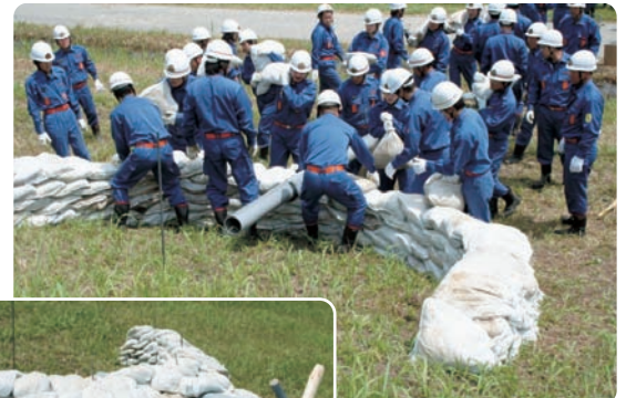
▲漏水の拡大を防ぐ月の輪工法
