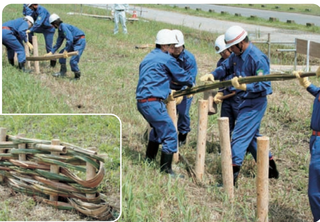
堤防などの崩壊を防ぐ竹柵工法
