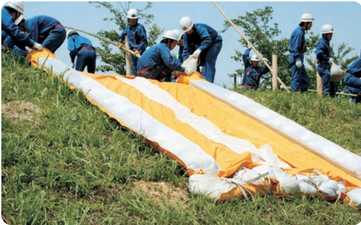
堤防などの崩壊を防ぐ竹柵工法
