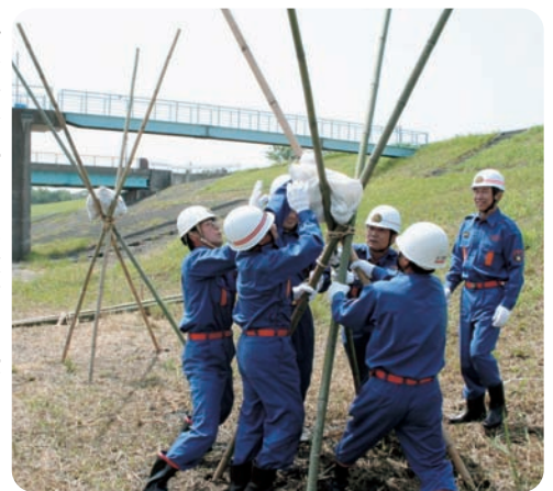
亀裂拡大を防ぐ五徳縫い工法
