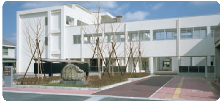
完成した中学校北校舎
