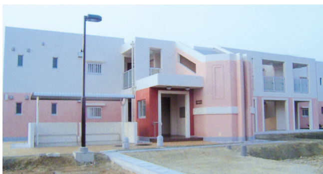
町営住宅 大堰団地 A棟
