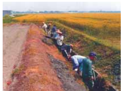
永年放置されていた開水路の泥上げを実施しました。(上高橋水土里の会)
