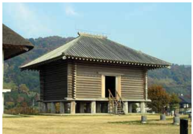
復元するとこんな建物に 床を支える柱が見える。 (茨城県つくば市 平沢官衙遺跡)
