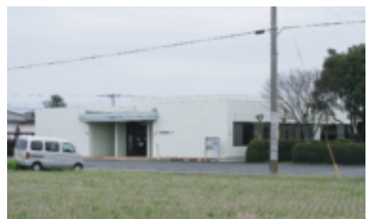
▲校区センター改修工事
