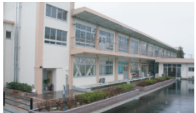
▲大堰小学校耐震化及び改修工事
