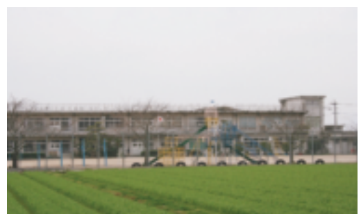
▲学校省エネ改修等工事
