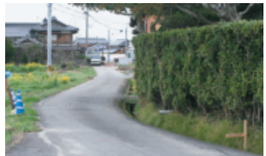
▲道路改良事業(拡幅整備)
