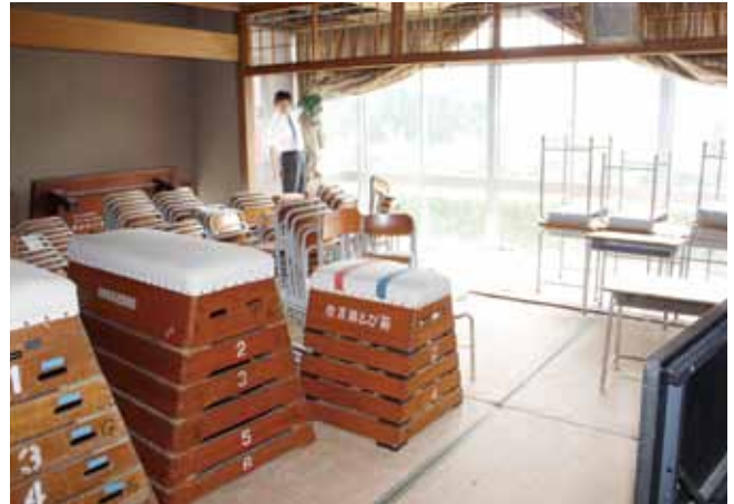
現在の西側倉庫の室内
