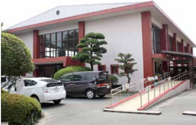
現在の屋内運動場の外観
