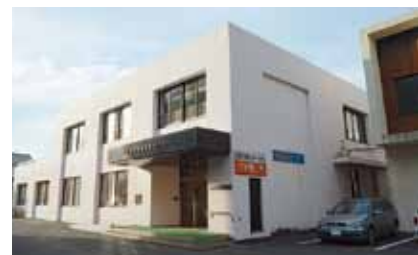
2階に多目的室を設ける等の改修を行います。
