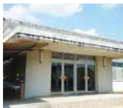
改修前の給食棟
