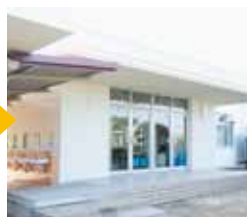
改修後の給食棟
