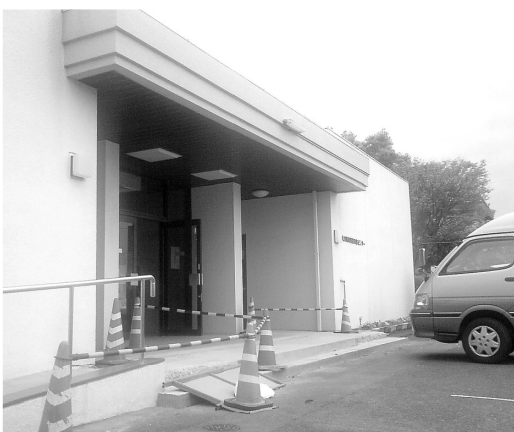
改修中の就業改善センター
