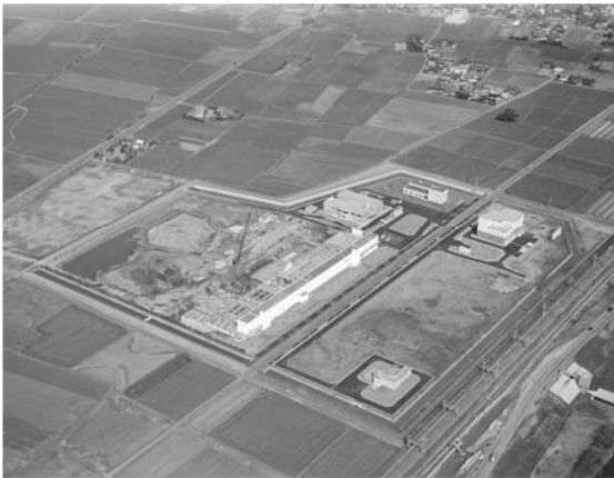
福童浄化センターはH20に稼働開始した
