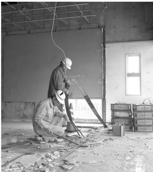
改修中の本郷小体育館
