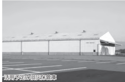
活用予定の旧灰保管庫
