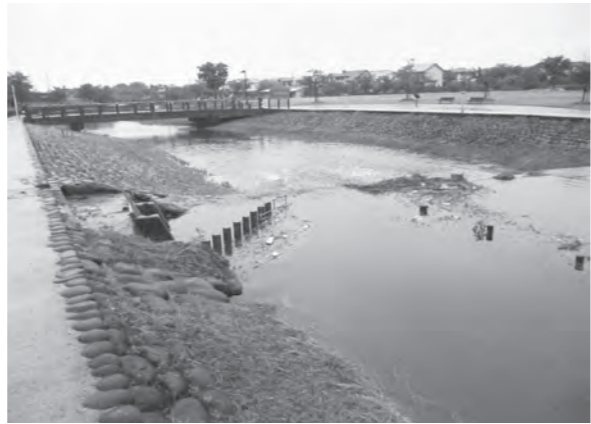
ごみが溜まる井堰部分（大刀洗公園）
