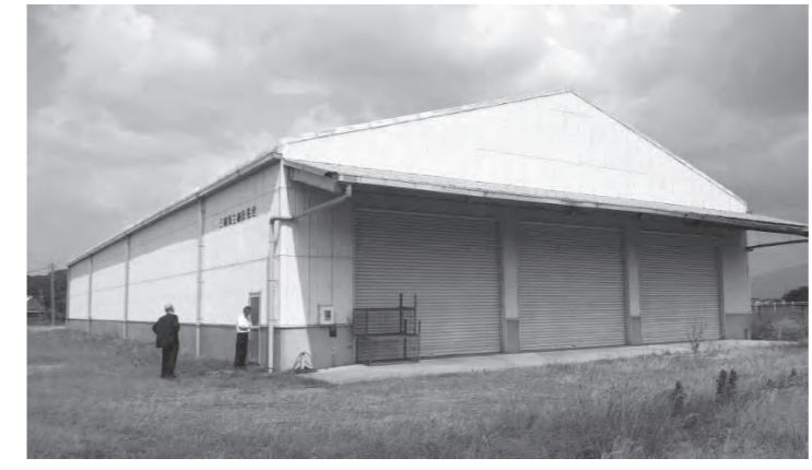
旧灰保管庫を改修しての開業が予定される
