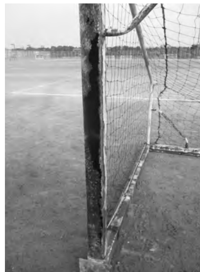
腐食が進んだゴールポスト
