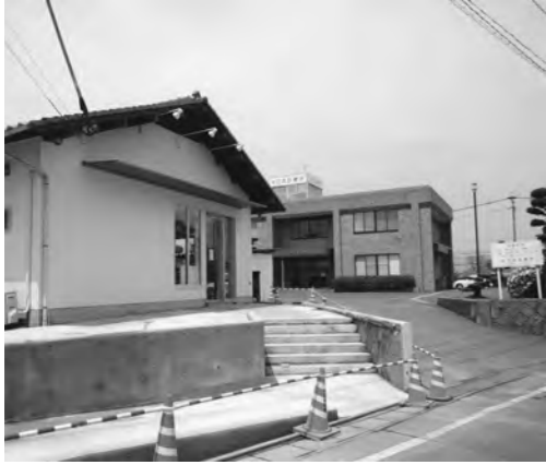
薬局へ改修中の宿舍(手前)と診療所
