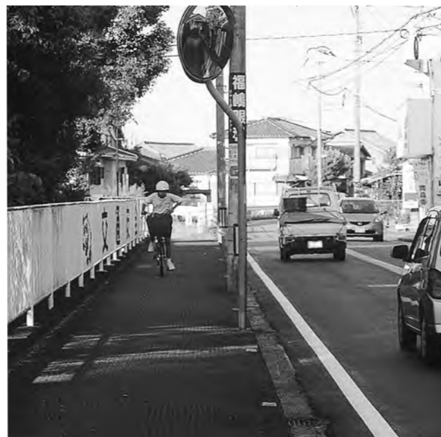
自歩道整備部分
