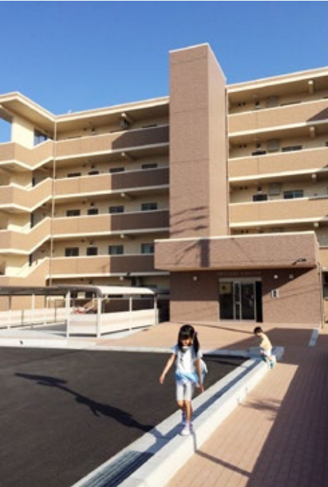
完成したスカイラーク菊池
