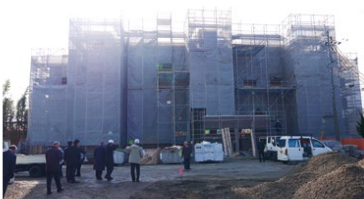
建設中のスカイラーク
