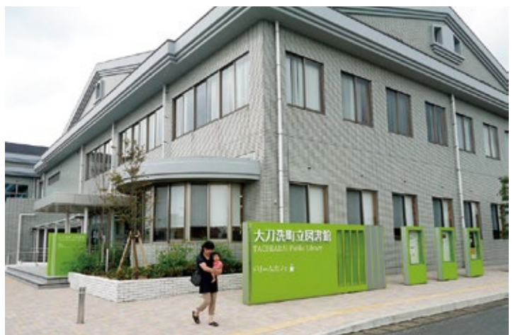
南側に新しく出入口を設置（図書館）
