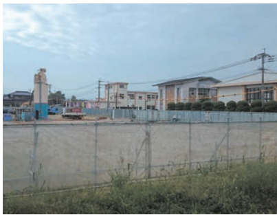
2棟目の建設予定地(上高橋)
