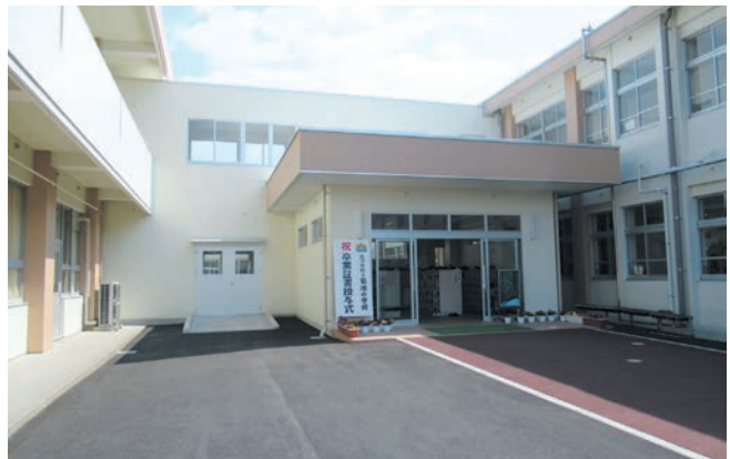
改修が完成した菊池小学校
