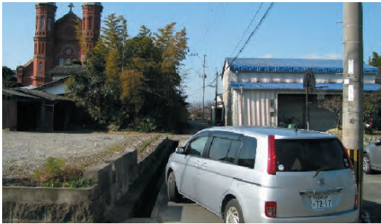
水路と電柱があり右折が困難
