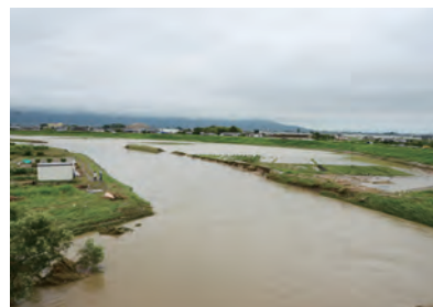
江戸橋下流側
