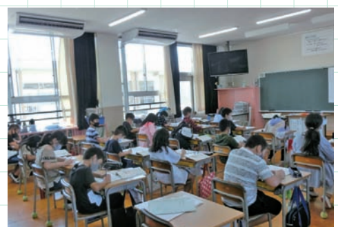
⑧空調機設置工事
