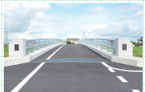
⑨公共土木施設災害復旧(菅野橋)
