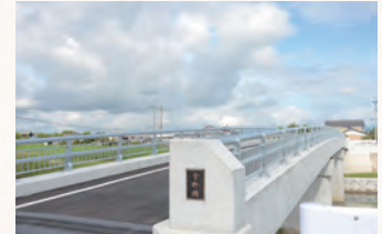
▲復旧完了した菅野橋
