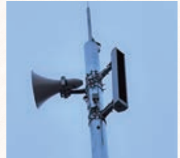
▲整備中の防災行政無線
