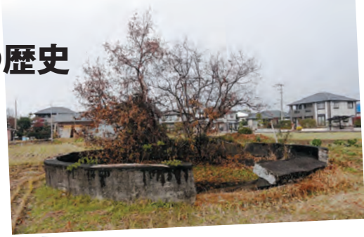
技能者養成所内防火水槽跡
