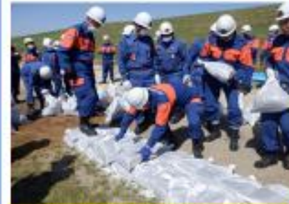
積み土のう工法
