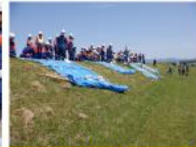
シート張り工法
