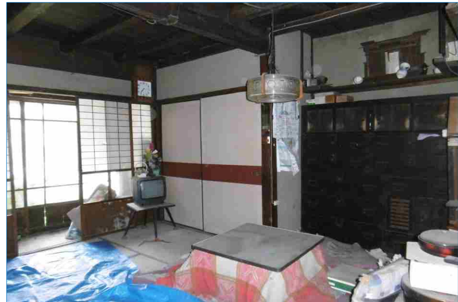
修理前:1階居間
