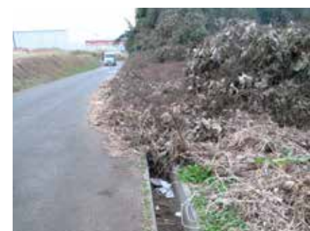
公道にはみ出ている危険
