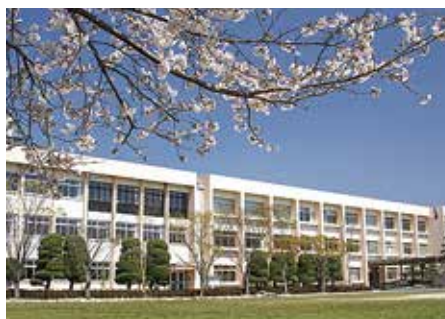
校舎なども久留米市が継承する
