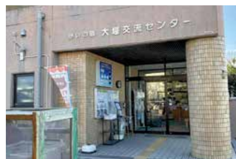
経年劣化が進む交流センター
