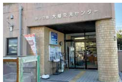
経年劣化が進む交流センター
