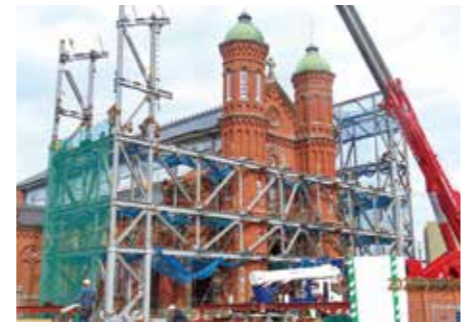
耐震工事が進む天主堂
