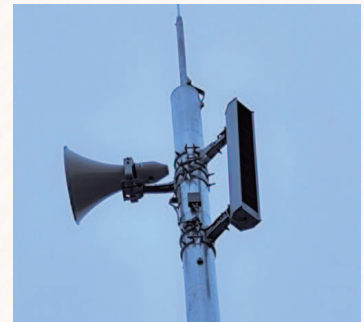
▲整備中の防災行政無線
