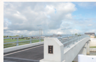
▲復旧完了した菅野橋
