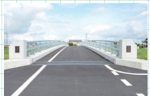
⑨公共土木施設災害復旧(菅野橋)
